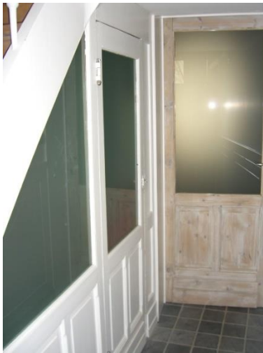
Keldertoegang onder de trap naar de 1 e verdieping (foto: Tino Balazs)
