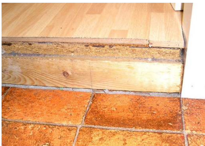
Soepele isolatie tussen een keperwerk bovenop een deel van een bestaande vloer (foto: Cees Bakker)
