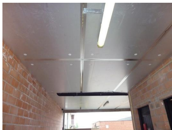
Isoleren van een vloer boven de buitenomgeving (onderdoorgang) met vormvaste isolatieplaten. (Foto: Isolatie Verhoeven)
