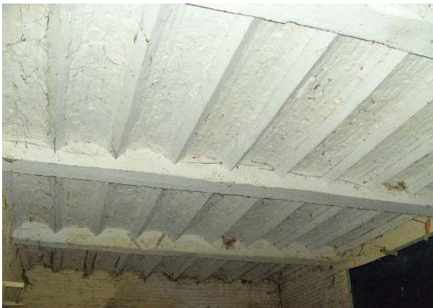
Kelder met gewelfd plafond. (Foto: Ets. Labeau Jérémie)
