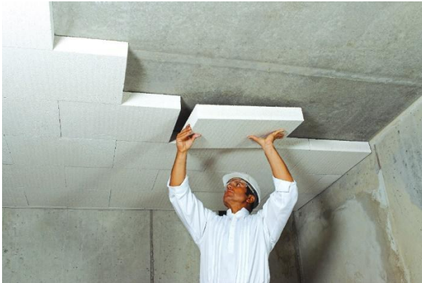
Isoleren van een vlak plafond met vormvaste isolatieplaten. (Foto: Xella)
