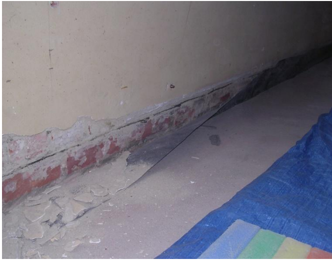
Omhoog plooiën van het vochtmembraan tot boven het niveau van de waterkerende laag in de muur. (Foto: Evelien Willaert)
