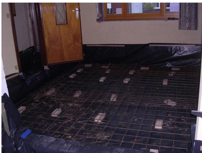
Plaatsing van een PE-folie als vochtmembraan, tegen de muren omhoog geplooid tot boven de waterkerende laag. (Foto: Evelien Willaert)
