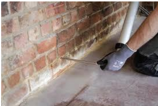
Injecteren van een muur tegen opstijgend vocht boven de vloerconstructie. (Foto: Buildwise)
