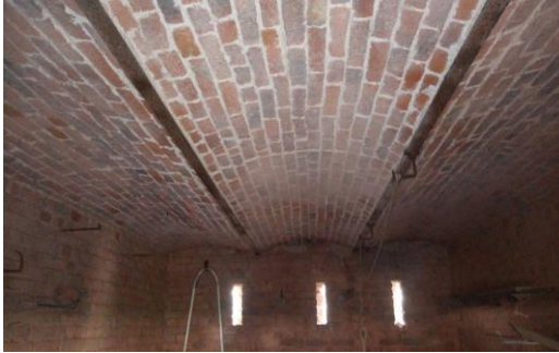
Gewelfde vloer boven kelder in baksteenmetselwerk. (Foto: ForumConstruite)
