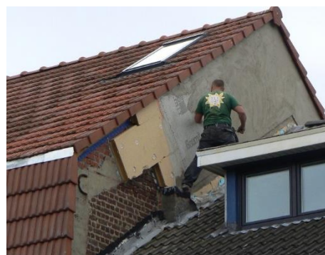
Buitenisolatie tegen het vrijstaande deel van de muur op de perceelsgrens, foto arch. G. Demey
