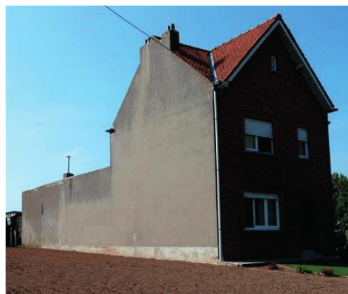
Niet-geïsoleerde vrijstaande muren op de perceelsgrens zorgen voor veel warmteverliezen, foto Maarten Van Acker (UA)
