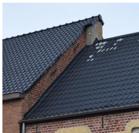
Niet-geïsoleerde muur op de perceelsgrens, boven het lagergelegen dak, foto Diksimm
