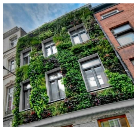
Niet-grondgebonden gevelgroen, foto Plant Design, arch. Matz-Haucotte
