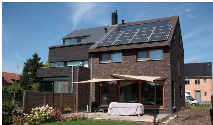
Passieve houtskeletbouwwoning (2010), foto B. Vanderwegen
