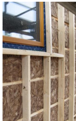
Dubbel keperwerk met twee lagen soepele isolatie, illustratie Dialoog vzw, foto arch. E. Willaert
