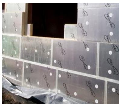
2 e laag isolatieplaten met afgekleefde naden
