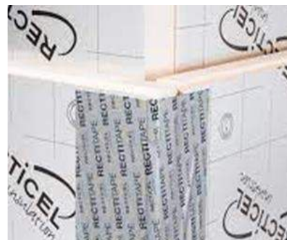
2 e laag isolatieplaten met afgekleefde hoeken, foto's Recticel
