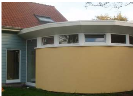
Gebogen wand met gevelpleister, foto arch. D. Van Clé
