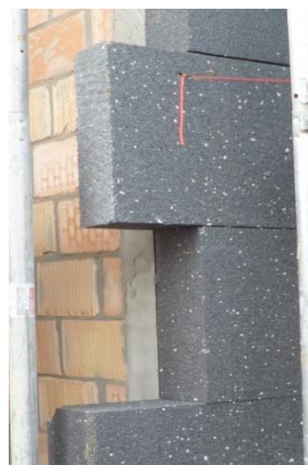
Verspringende voegen ter hoogte van de hoeken, foto: arch. D. Van Clé
