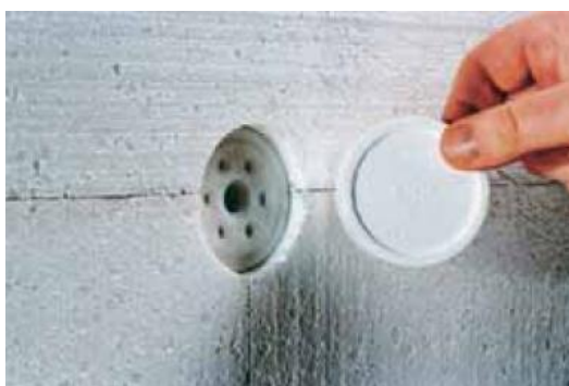
Isolerende sluitringen, foto Handboek Etics, IVP
