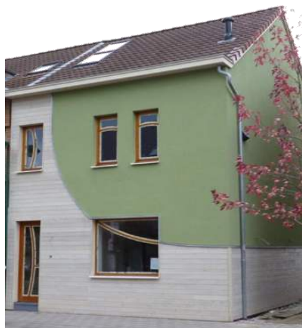
Combinatie van gevelpleister en houten beplanking, foto arch. D. Van Clé
