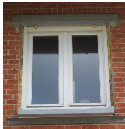
Koudebruggen tussen gevelisolatie en schrijnwerk wegwerken door afslijpen van het metselwerk boven en naast het raam en nieuwe dorpel, foto arch. D. Van Clé
