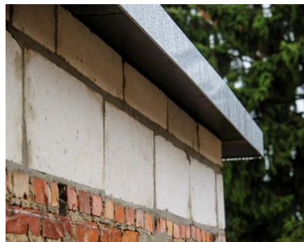
Dakrandaanpassing met isolerende bouwblokken en een dakoversteek, foto L. Loeckx
