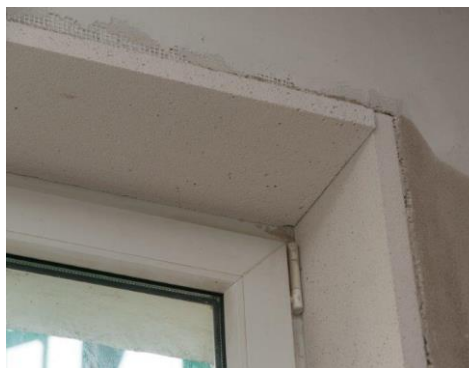
Raamaansluiting: werk koudebruggen weg ter hoogte van de dagkanten, foto's Xella
