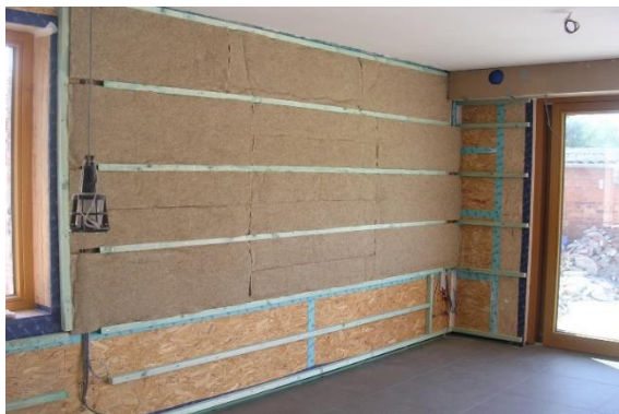
Bijkomende isolatie in de leidingspouw, foto arch. E. Willaert
