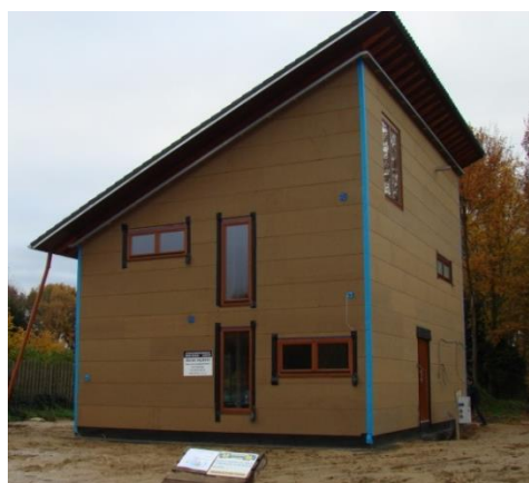
Houtskeletwanden met winddicht afgewerkt regenscherm, foto Dialoog vzw
