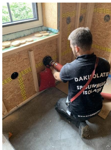
Inblazen van isolatievlokken in een houtskeletwand, foto Eco Protect
