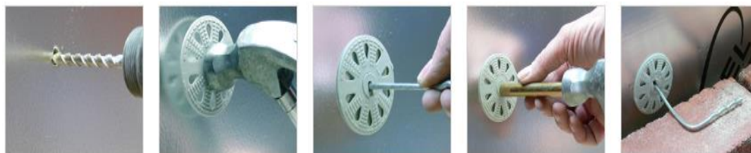
Spouwankers met plug, foto's www.massiefpassief.be
