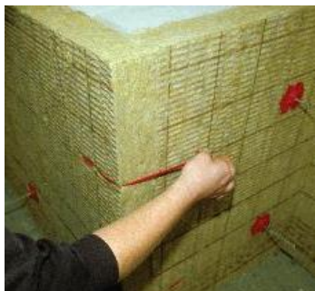
Openstaande hoeken vermijden met hoekankers bij halfharde isolatieplaten, foto Rockwool
