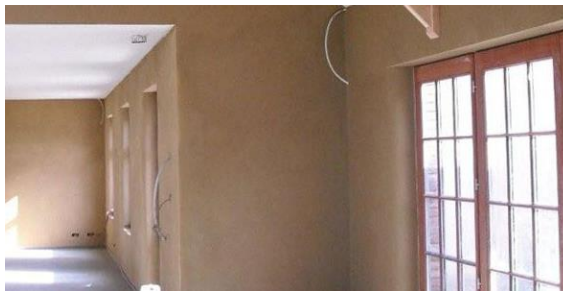
De binnenbepleistering verzekert de luchtdichtheid, foto BVBA Verstraete
