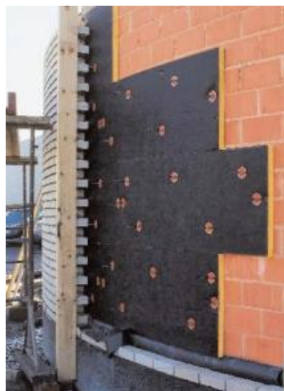
Gebogen wand met glaswolisolatie, foto www.baksteen.be
