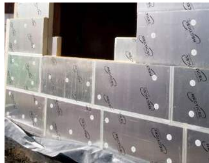
Vormvaste isolatieplaten in twee lagen met afgekleefde voegen, foto Recticel
