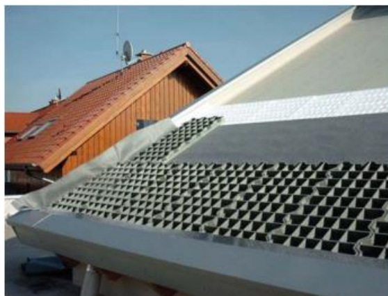
Bakken waarbij het substraat vastgehouden wordt, illustratie WTCB
