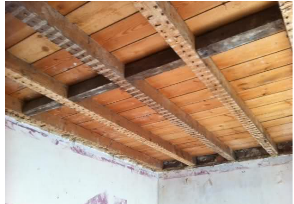
Zoldervloer zonder afwerking aan de onderzijde: geschikt voor isolatie tussen de draagstructuur (foto: ...)
