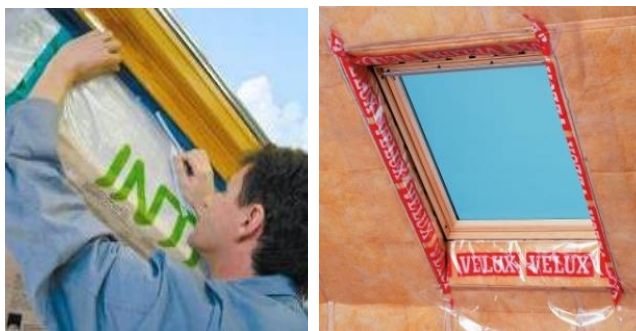
Luchtdichte aansluiting tussen dakvlakraam en het dampscherm onder de dakisolatie, illustraties pro clima, Velux
