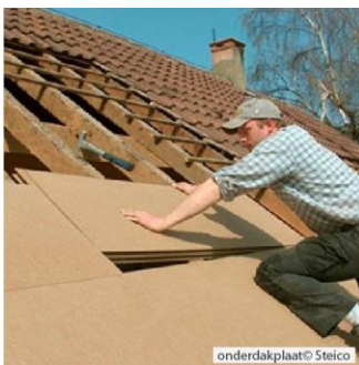
Houtwol sarkingplaten en onderdakplaten (afbeeldingen: Steico, Pavatex)
