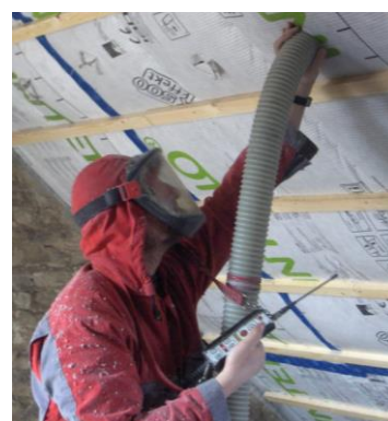
Isolatiemateriaal inblazen (foto: arch. J. Van den Broeke)
