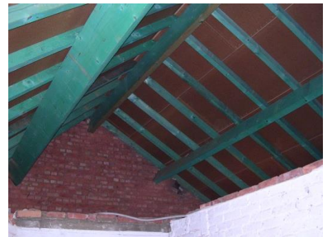
Keperdak met onderdak, klaar om te isoleren (Foto: E. Willaert)
