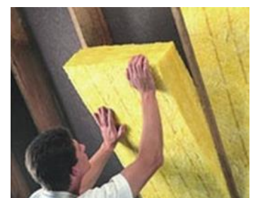
Spantendak isoleren (foto: Isover)
