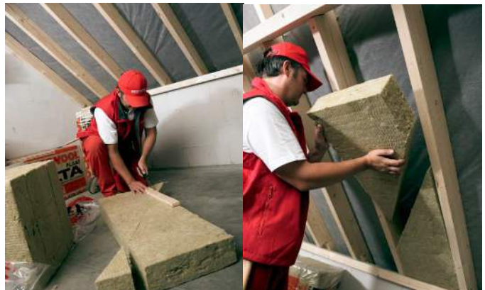
Isoleren zonder veel materiaalverlies met driehoekige platen (foto's: Rockwool)
