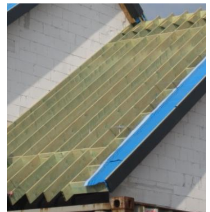
Dak met hoge kepers (Foto: arch. D. Van Clé)
