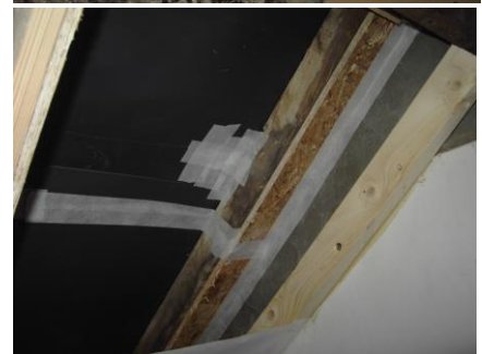
Verbeteren van de winddichtheid van een bestaand onderdak (Foto's: E-advies)
