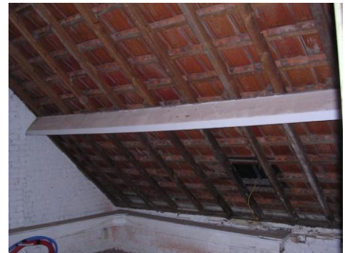
Bestaand hellend dak zonder onderdak (Foto: E. Willaert)
