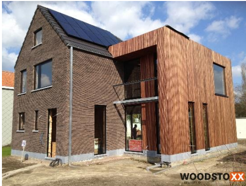
Hardstenen sokkel tegen opspattend vocht (Afbeelding: woodstoxx.be)
