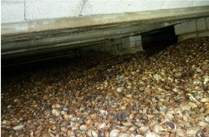
Met een laag schelpen van minstens 30 cm dik vermijd je condensatie tegen het plafond van de kruipkelder. (Foto: Ecomat)
